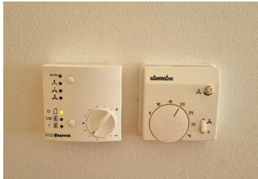
Abbildung 10, Thermostat und Ventilatoreinstellung im Wohnzimmer/Essbereich
